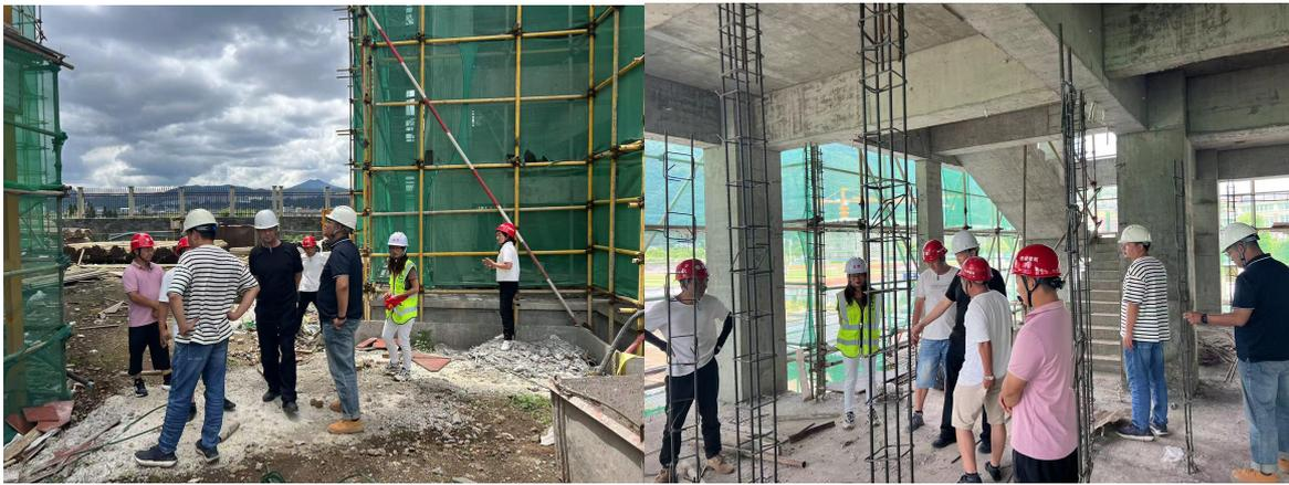
检查结果：基础工程无问题，结构工程钢筋绑扎部分偏移，进行整改后进行下一步工序。悬挑式卸料平台螺栓未拧紧，无垫片，整改并通过验收后再进行使用。
