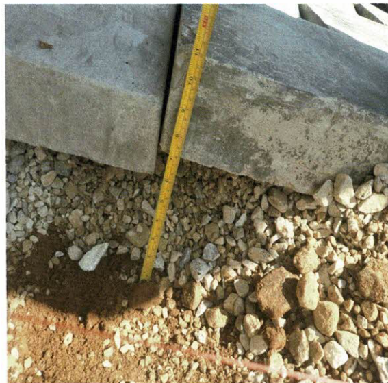
拦河坝坝体上游坝坡混凝土预制块垫层铺筑厚度不满足设计要求
